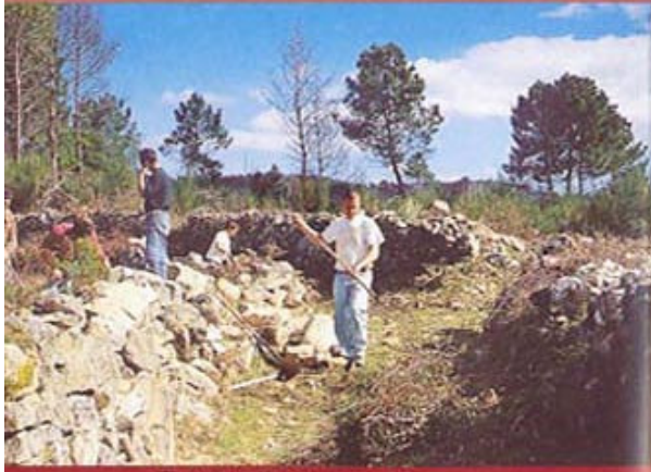
Trabalhos de recuperação
